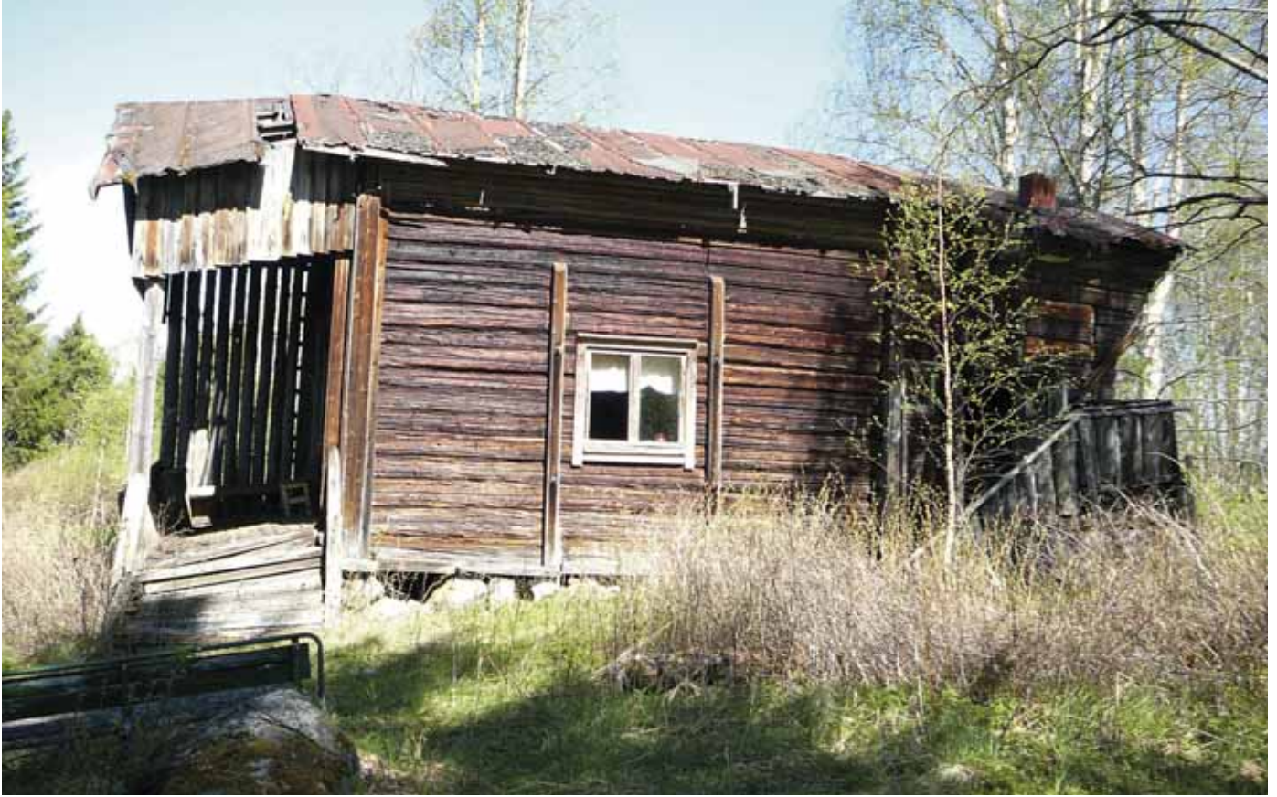
Monolan talon aitta on huonossa kunnossa, mutta suunnitelmia sen kunnostamiksi on tehty.
